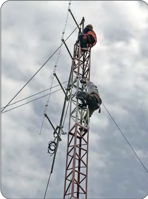
Installing a radio antenna. Courtesy Colette Baudais.
